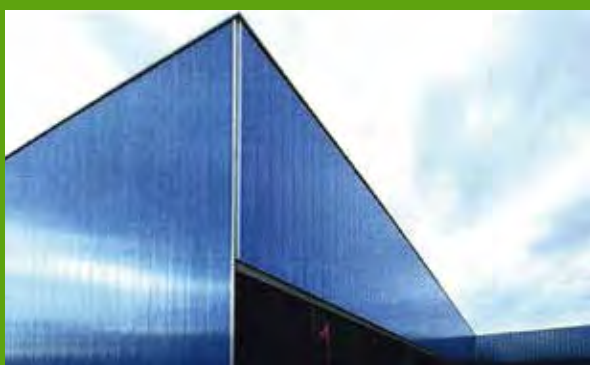
2.1 Sistema modular de policarbonato celular con protección U.V. para paramentos verticales y cubiertas translúcidas
